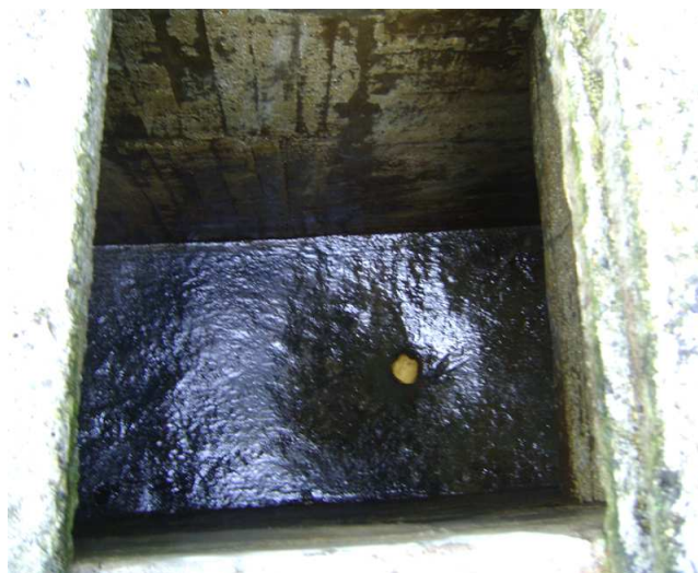
Foto 15. Desagüe en la zona de sedimentación
