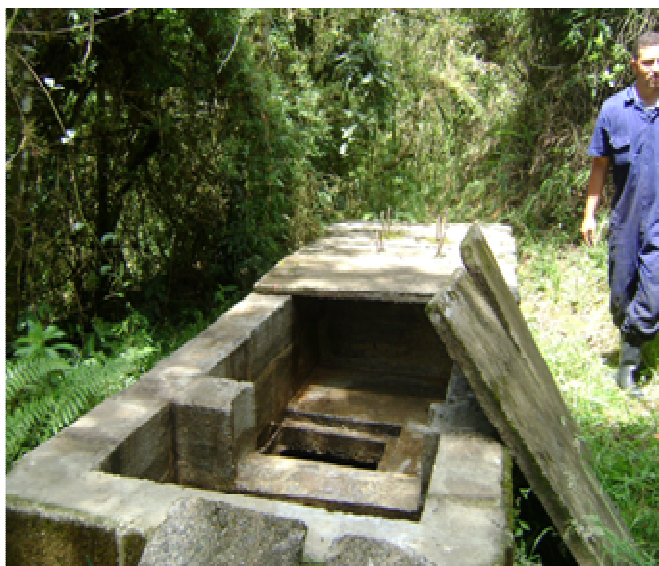
Foto 7. Desarenador del sistema de captación San Francisco.
