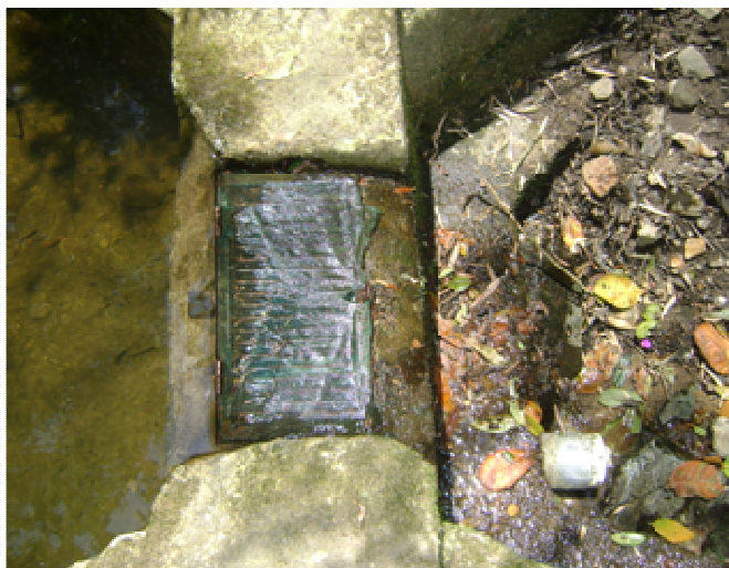
Foto 9. Rejilla de captación bocatoma Montenegro
