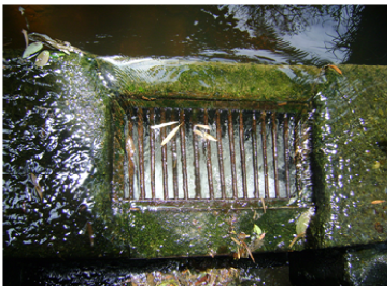
Foto 4. Rejilla de captación bocatoma San Francisco.
