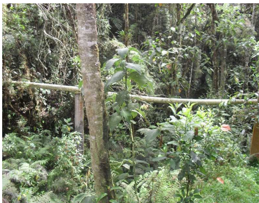
Foto 16. Tramo de conducción elevado.
