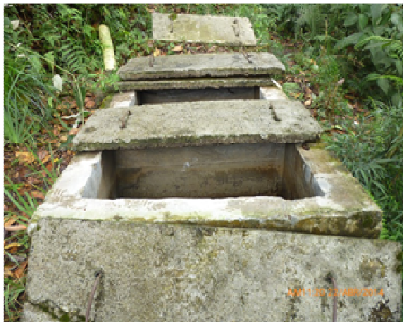
Foto 13. Desarenador Sistema Montenegro
