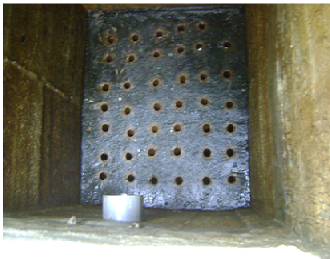
Foto 8. Pantalla deflectora a la salida del desarenador.
